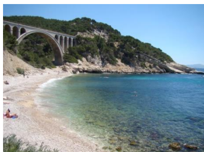
Calanque des eaux salées
